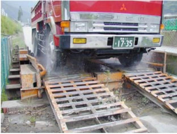
・粉じん対策として工事区域及び土砂仮置場からの出口に、スパッツ(タイヤ洗浄装置:湿式)を設置
