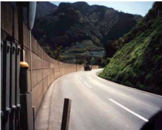
・工事用道路において遮音壁を設置
