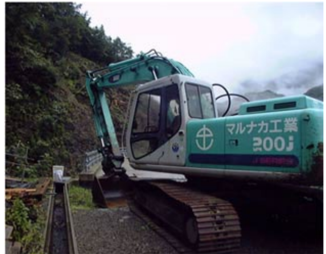
・低騒音型建設機械の使用(バックホウ)
