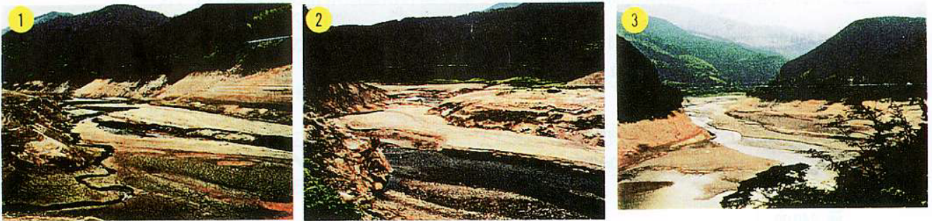
図 4.2.3.3-5 市房ダムの濁水発生時の貯水池末端付近の状況(平成 10 年 9 月)
