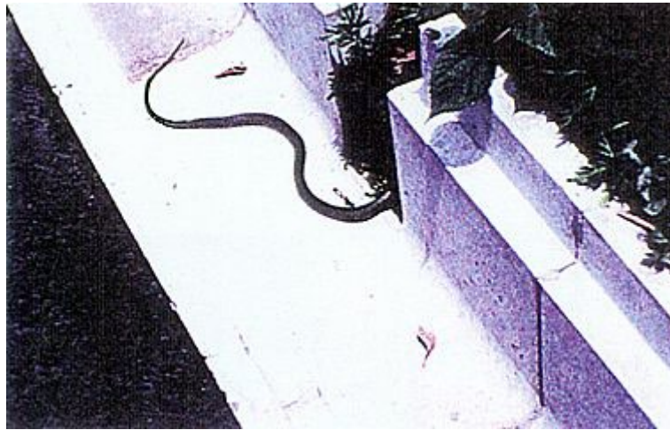
図 4.4.2.3-7 切り欠きの設置状況
