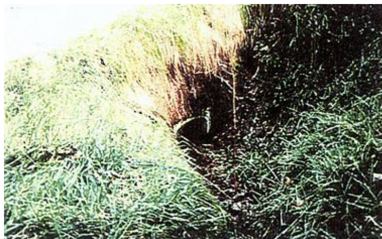
図 4.4.2.3-6 横断管の設置状況
