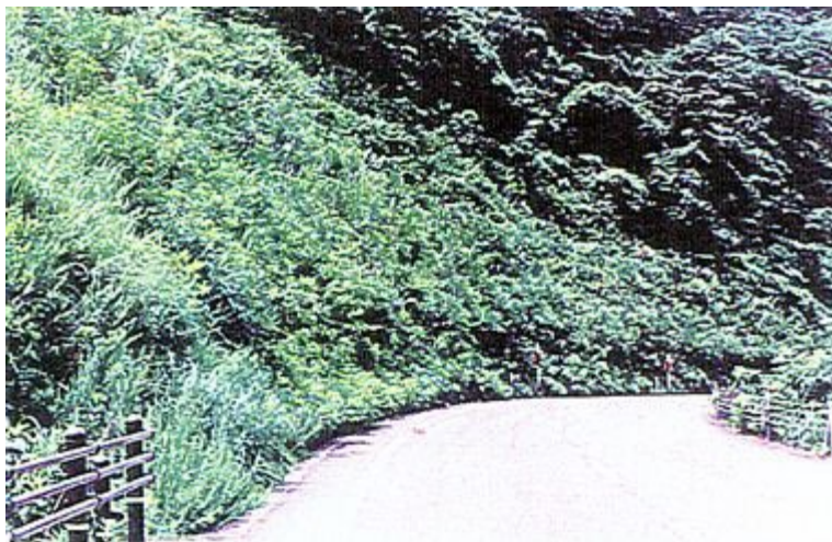
図 4.4.2.3-5 掘削法面の植栽
