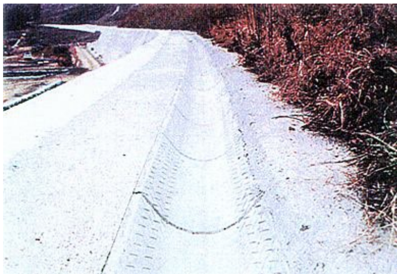
図 4.4.2.3-8 緩傾斜側溝の設置状況
