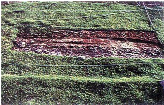
図 4.4.2.6-6 営巣地周辺をそのままの状態で保存しながら法面緑化を実施
