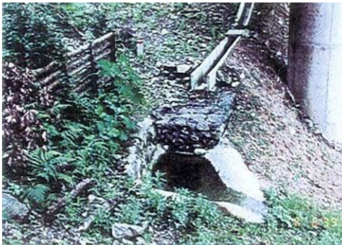
図 4.4.2.6-9 清楽地区の付替道路の橋下部に設けられた水飲み場
