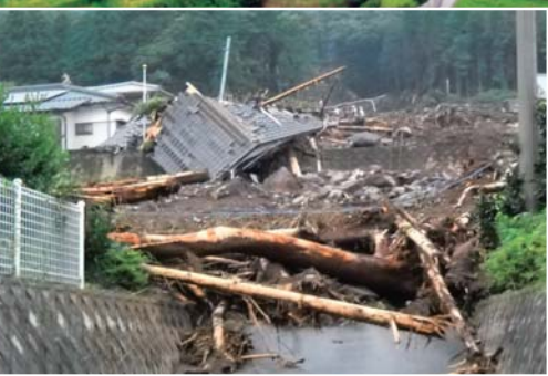
土石流に押しつぶされた家屋(熊本県南阿蘇村新所地区)
