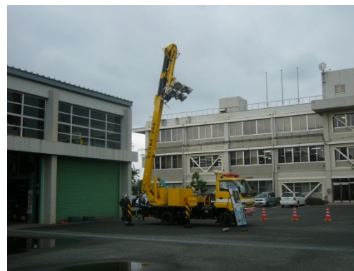
照明車の設置状況
