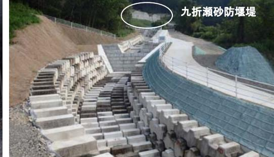
【補足】溪流保全工とは、砂防堰堤からの流水を安全な箇所まで流すために設置する砂防設備の事です。
