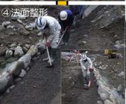
続いて護岸の法面部の施工に入ります。まず、施工の支障となるような浮石、崩土等を除去・清掃し、機械で締め固めます。
