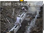
決められた位置・高さ にコンクリートで作ら れた護岸の基礎を設置 し、空洞部にコンク リートを流し込み基礎 設置完了です。
