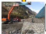
川の堆積土砂から採取した石のかみ合わせを石工さんが1つ1つ確認しながら次の石を選び、1つ1つクレーンで設置位置にまで吊り上げて運びます。
