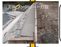
石積みをした天端(最上部)の高さを均一にするために、コンクリートを金ゴテを使用し丁寧にきれいに仕上げます。
