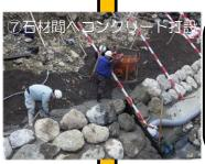
1段の石の設置が完了 したら、石同士をくっ つけるためのコンク リートを投入します。 コンクリートを隅々ま で流し込むためにバイ ブレータを使用します。
