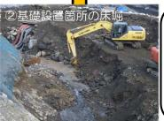
護岸の土台となる基礎 を設置するために河床 を掘削します。 掘削時の湧水は、排水 ポンプにて排除します。
