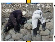
石に付着したコンク リート等をブラシを使 いきれいにし、上の列 の作業に移行します。 1段ずつ手作業で丁寧 に作業を行います。
