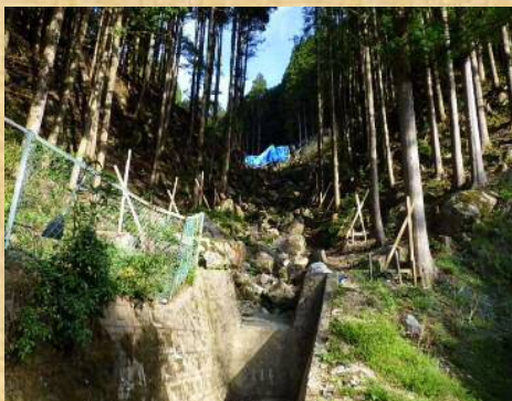
砂防堰堤下流側
