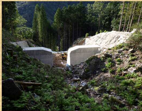
砂防堰堤上流側
