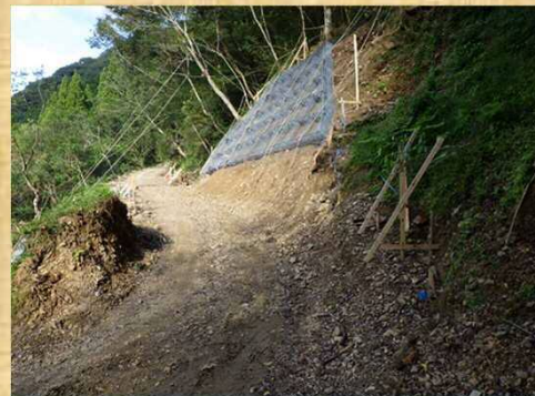
工事用道路終点側撮影
