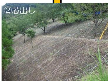
材料を決まった位置に設置できるよう、ポリプロピレンロープで位置決めを行います。カーブや凹凸のあるところでは間隔を調整して、位置を決めます。
