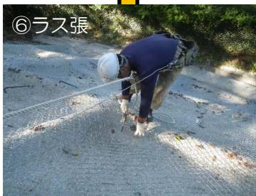
ラス金網をのり面全体に対して覆うように張り付け、アンカーピンを打設してのり面になじむように仕上げます。
