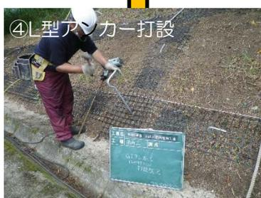
ジオグリッドを設置後、GTフォームがずれないようにL型のアンカー（ピンのようなもの）で、固定します。
