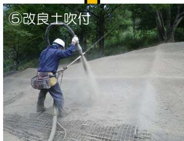
配合計算表にしたがって計量・混合した改良土をジオグリッドの上面から充填するように吹き付けて、所定の形状ののり枠構造を造成します。
