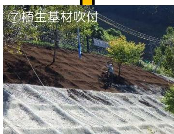
ヨモギ・シロクローバなど5種類の種子と肥料・養生材を混ぜた植生基材をのり面に吹き付けます。
