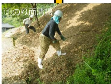
施工の支障になるようなのり面の雑木・浮石・崩土等を除去・清掃します。
