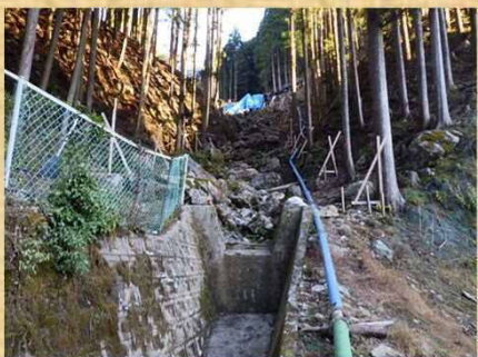
砂防堰堤下流側
