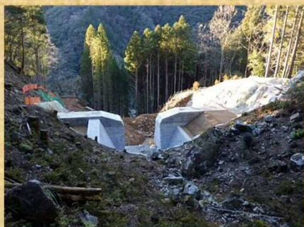
砂防堰堤上流側
