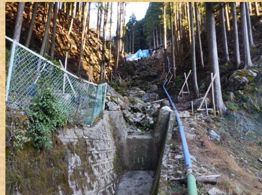
砂防堰堤下流側
