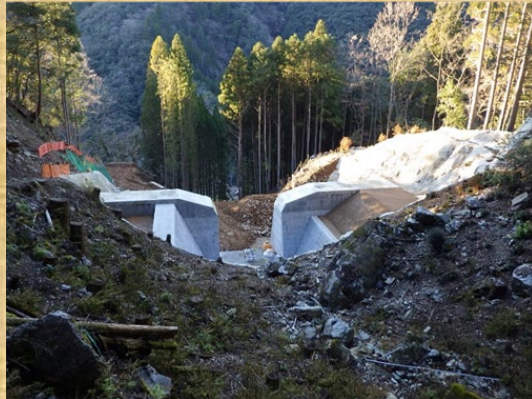
砂防堰堤上流側
