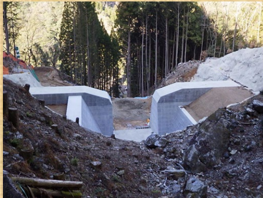
砂防堰堤上流側
