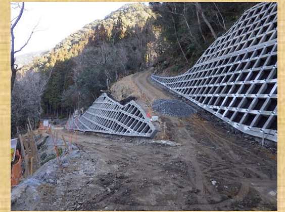
工事用道路終点側より撮影
