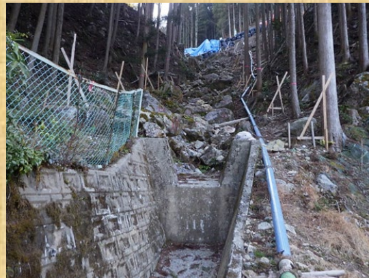
砂防堰堤下流側
