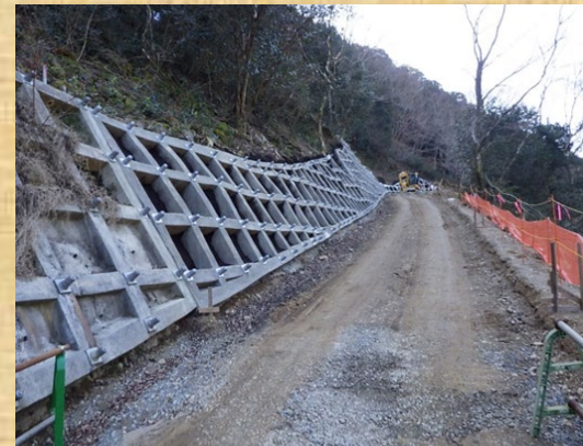
工事用道路起点側より撮影
