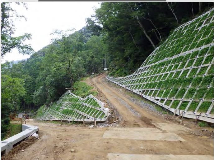
工事用道路終点側撮影
