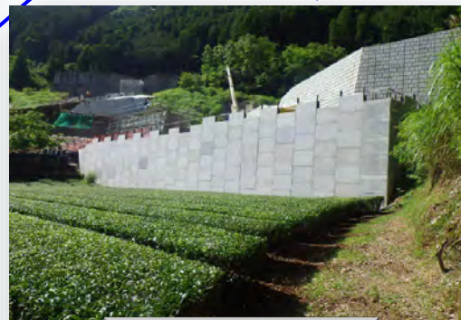
【7号外部保護工】
