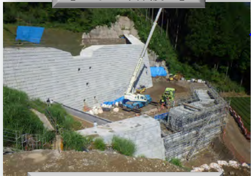
【コンクリート副堰堤工】
