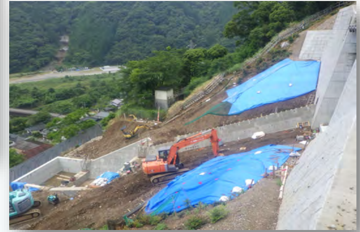
左岸側より右岸側
