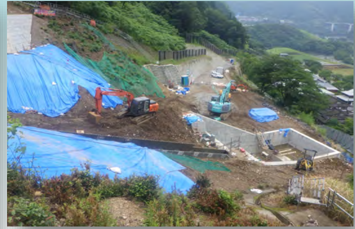
右岸側より左岸側
