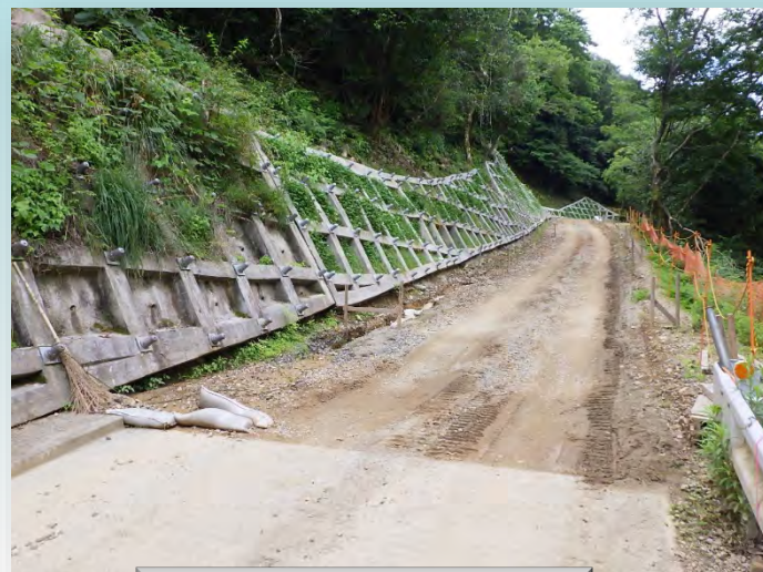
工事用道路起点側より撮影
