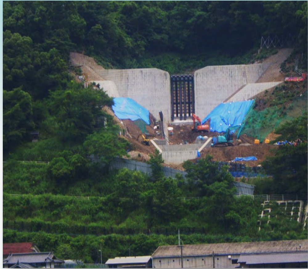
高野川第2砂防堰堤 正面
