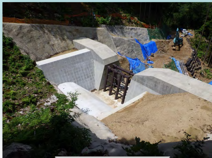
砂防堰堤上流側より撮影
