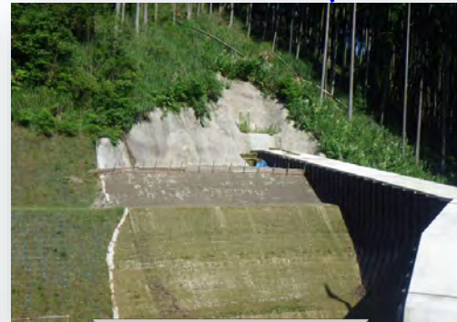
【本堤上流側盛土】
