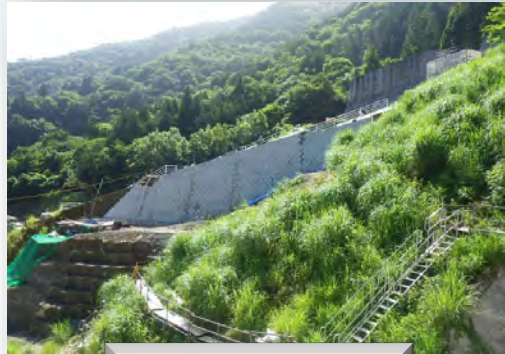
【6号外部保護工】
