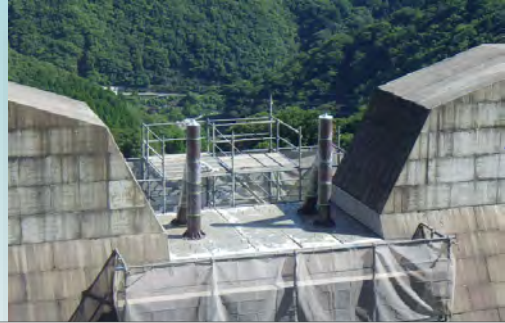
【鋼製堰堤工：九折瀬第1砂防堰堤】
