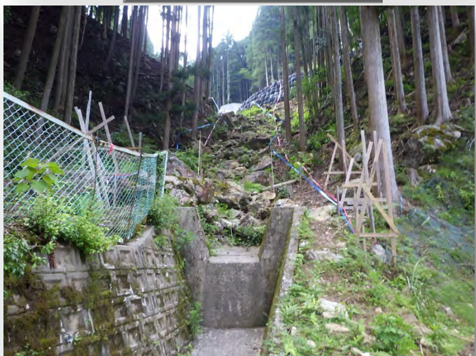
砂防堰堤下流側より撮影
