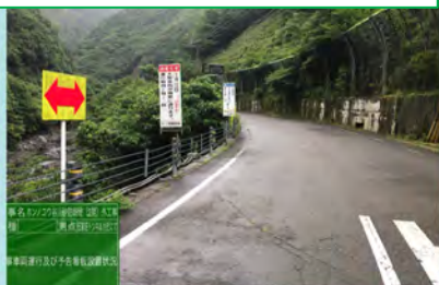
工事車両運行お知らせ看板設置箇所 国道445号(五家荘トンネル付近)
