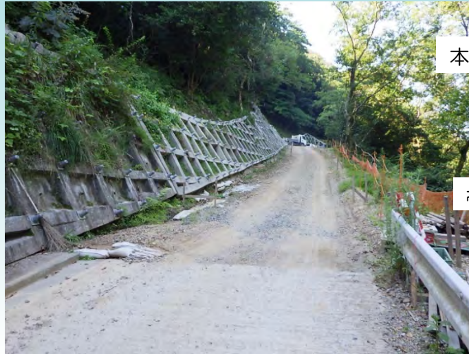
工事用道路起点側より撮影
