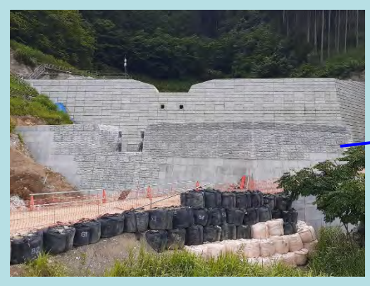
【コンクリート副堰堤工】
