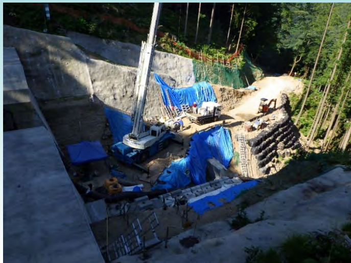
砂防堰堤上流側より撮影
