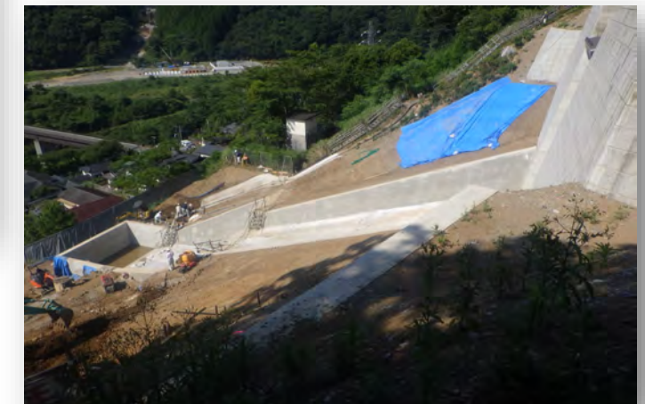
左岸側より右岸側
