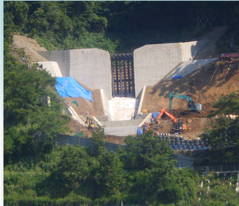
高野川第2砂防堰堤 正面
