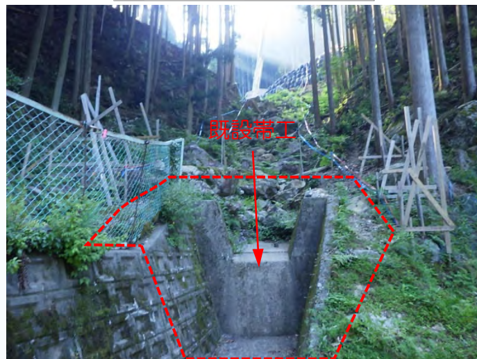
砂防堰堤下流側より撮影
