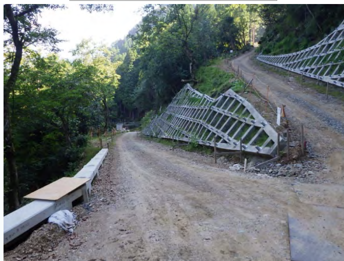
工事用道路終点側撮影
