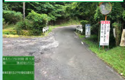
工事車両運行お知らせ看板設置 久連子神社付近
