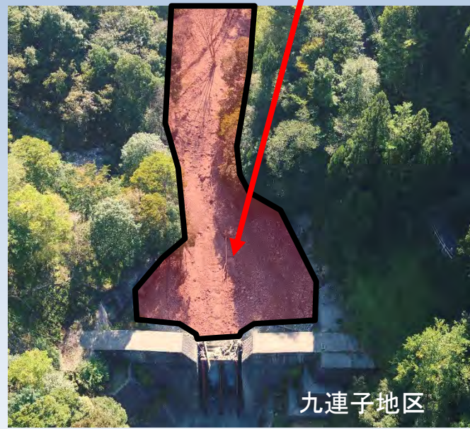
進捗状況写真 9月20日(空撮)
