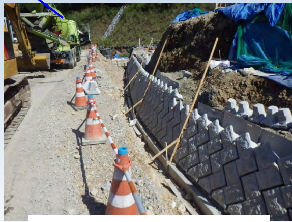
【外部保護工：ブロック積み】
