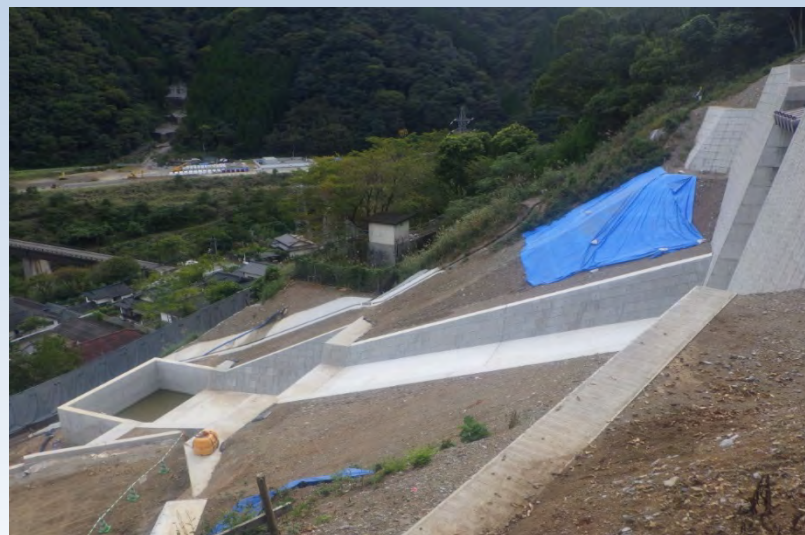
左岸側より右岸側
