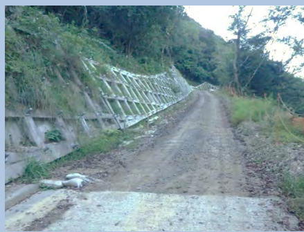
工事用道路終点側撮影
