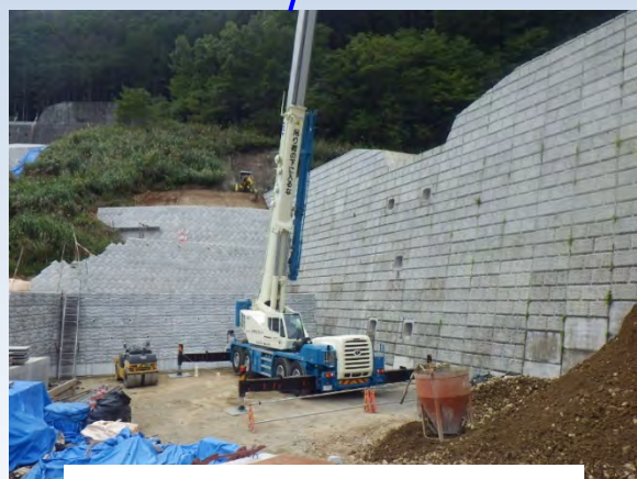
【本堤右岸：間詰盛土】
