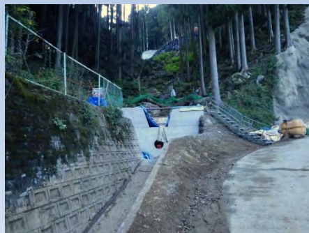
砂防堰堤下流側より撮影
