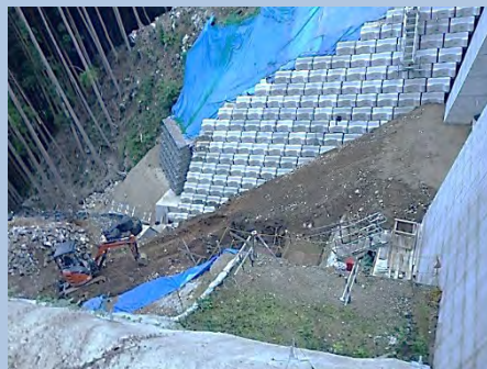
砂防堰堤上流側より撮影
