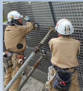
ホノコウ谷川砂防堰堤(2期)外工事現場
