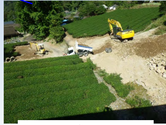
【大型土のう撤去：残土集積】
