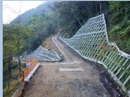
工事用道路終点側撮影
