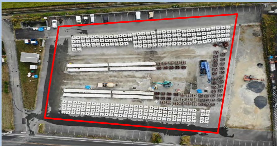
○根固めブロック製作 クラブロック S型 (2t) 進捗状況 10月29日現在 1170個/2076個
