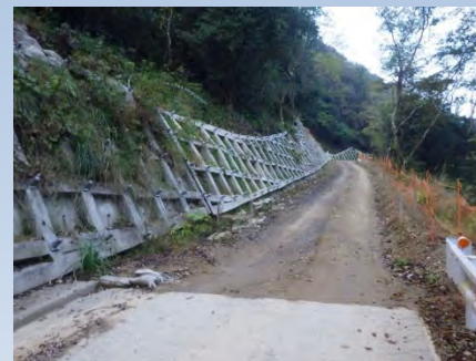
工事用道路起点側より撮影
