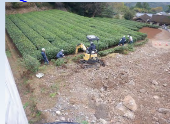
【大型土のう撤去：残土集積】
