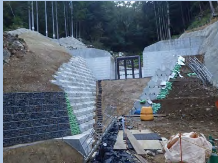
砂防堰堤上流側より撮影
