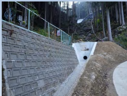
砂防堰堤下流側より撮影
