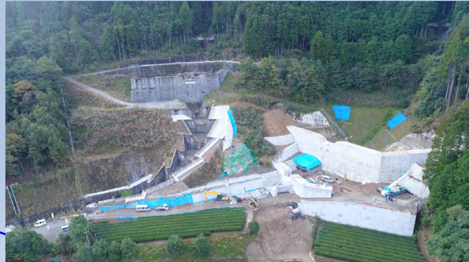
工事箇所(令和3年10月撮影)
