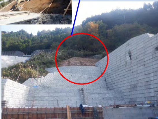
【本堤右岸：間詰盛土】
