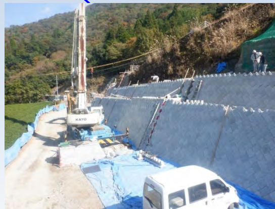
【外部保護工：ブロック積み】
