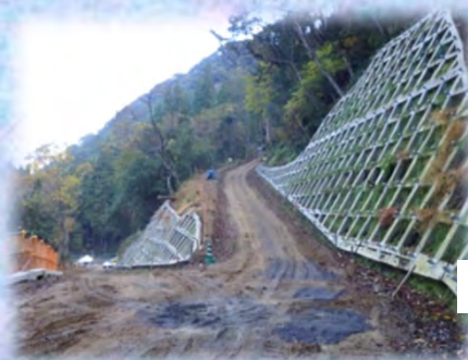
工事用道路終点側撮影
