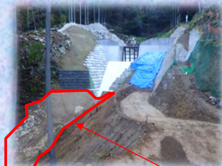
砂防堰堤下流側より撮影
