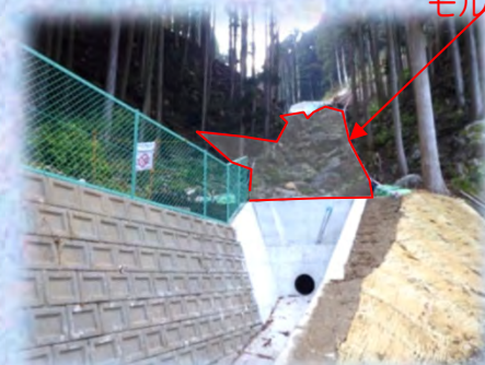
砂防堰堤下流側(墓地前)より撮影
