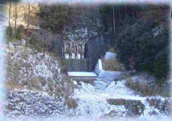
12/27 田口砂防堰堤
