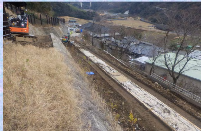
中間点より起点側
