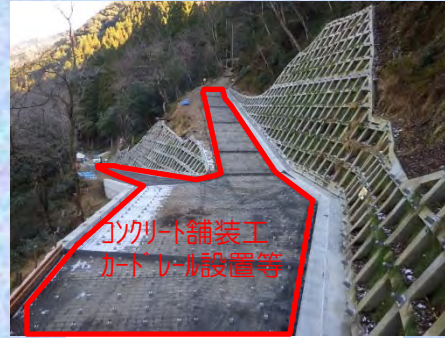
工事用道路終点側撮影
