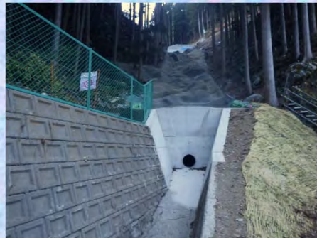
砂防堰堤下流側(墓地前)より撮影
