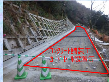
工事用道路起点側より撮影
