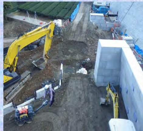
【7号外部保護工】
