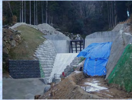
砂防堰堤下流側より撮影
