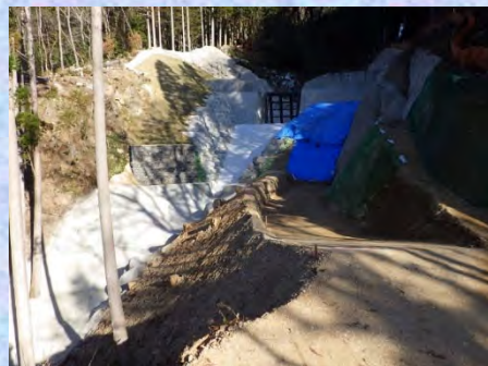
砂防堰堤下流側より撮影
