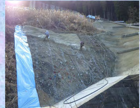
【モルタル吹付】
