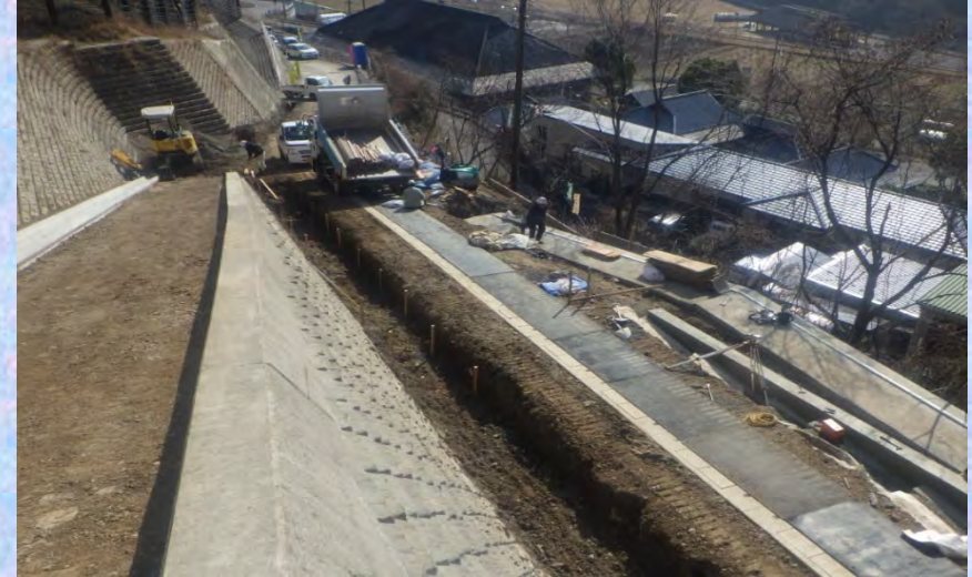
中間点より起点側
