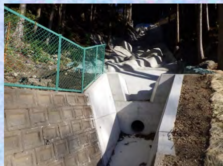
砂防堰堤下流側(墓地前)より撮影
