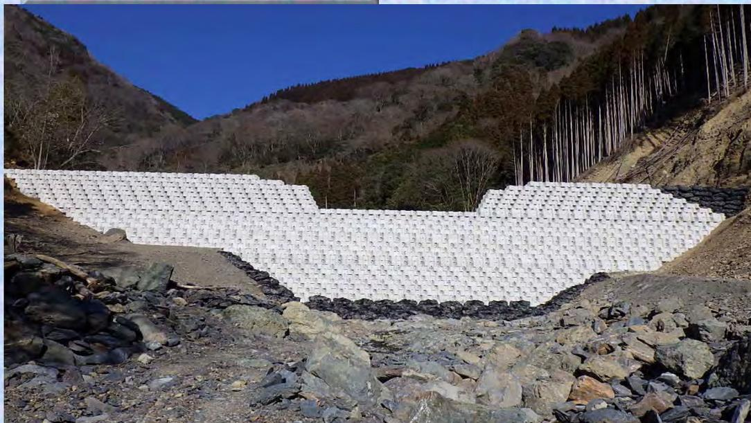
2月中旬でブロック堰堤の施工が完了し工事車両(ダンプトラック)での運搬が終了致しました。
