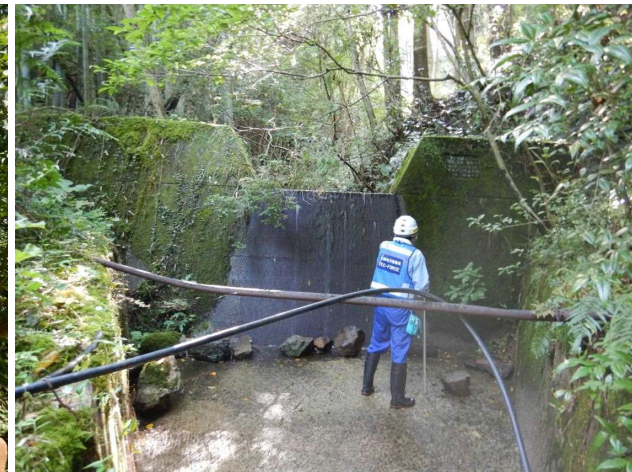
小森地先 現地状況 (土石流危険渓流の状況確認)
