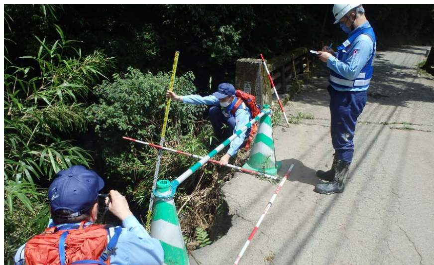
道路班による現地調査（熊本県人吉市）
