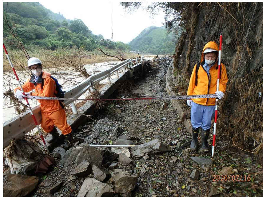
7/16 【道路班】被災状況調査(八代市)
