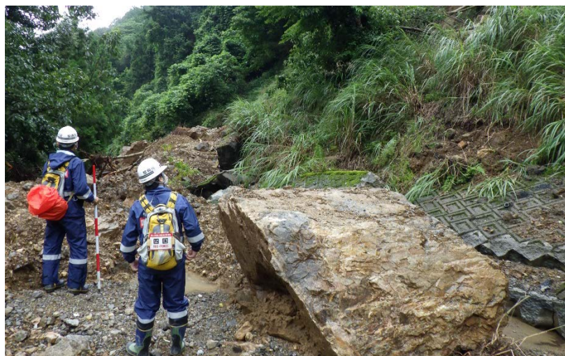
【球磨郡球磨村:被災状況調査(道路班)】
