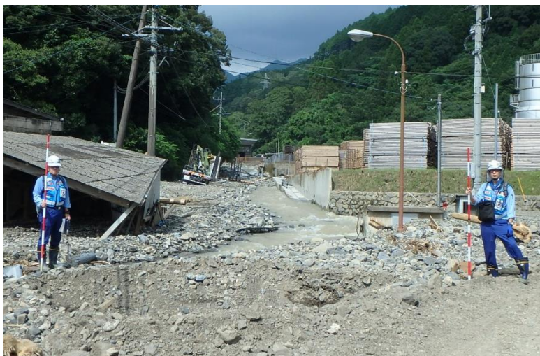
【球磨郡球磨村：被災状況調査(砂防班)】
