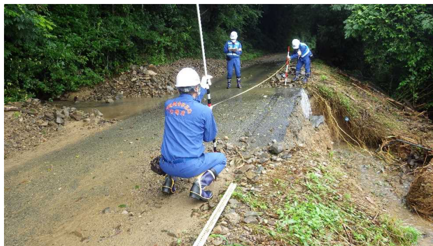
【被災状況調査】
