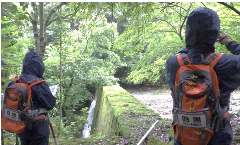
【球磨郡錦町:被災状況調査(河川班)】
