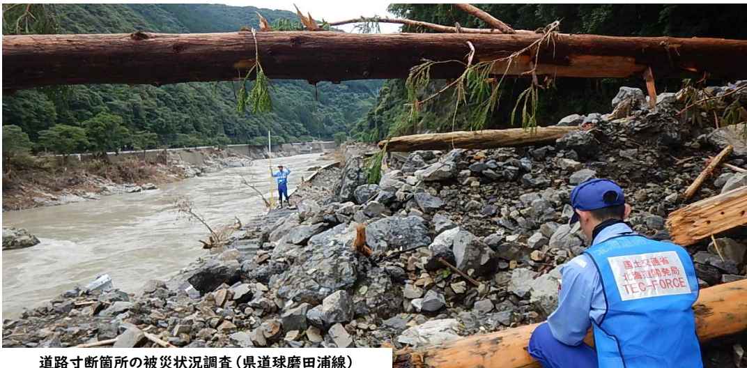
道路寸断箇所の被災状況調査(県道球磨田浦線)
