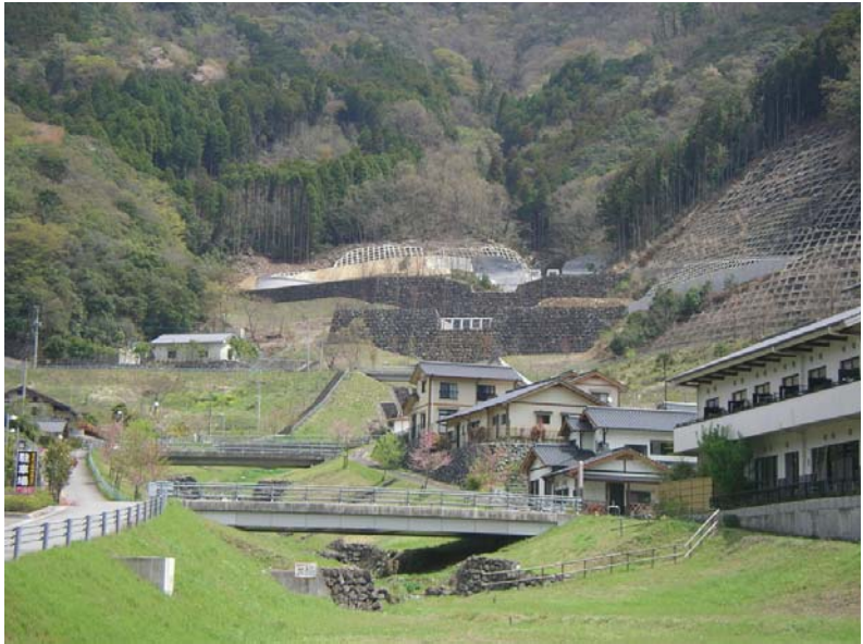
頭地地区 (田口・松本・下手流路工)
