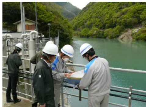
九電(株)との合同点検状況
