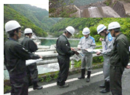
九電(株)との合同点検状況
