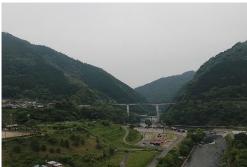
頭地大橋(下流方向): 春季 (調査日 令和4年5月23日)
