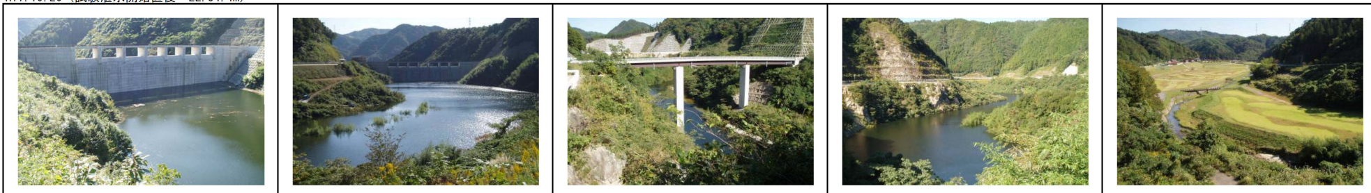
H17. 12. 7 (サーチャージ水位到達時 EL. 72. 7m)
