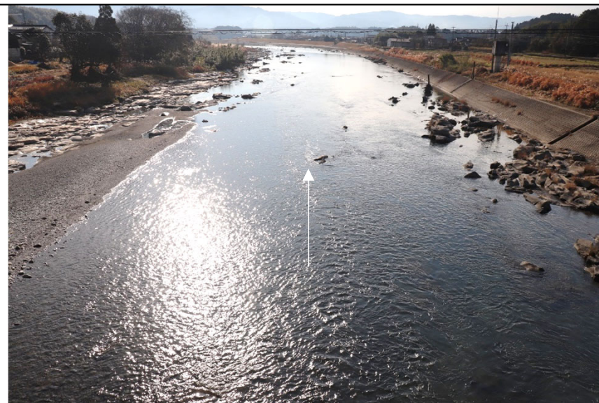
柳瀬地点 約7m 3 /s 時(令和2年12月22日撮影)
