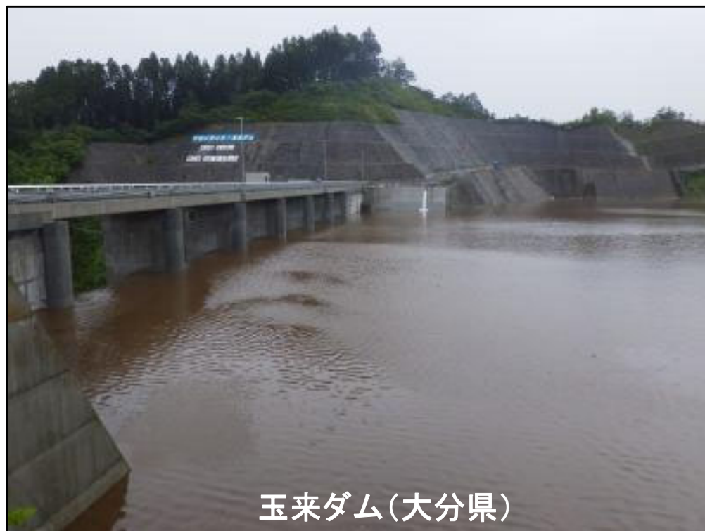
試験湛水状況(R4.9.19 8時 時点) 水位 EL.389.99m
