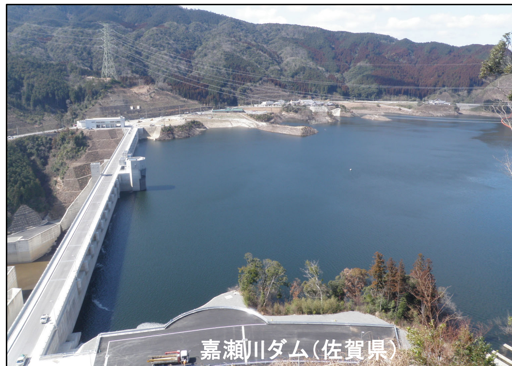
試験湛水状況(H24.3.12 時点) 水位 EL.292.44m
