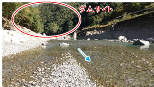
ダムサイトの下流に位置する早瀬から上流を望む
