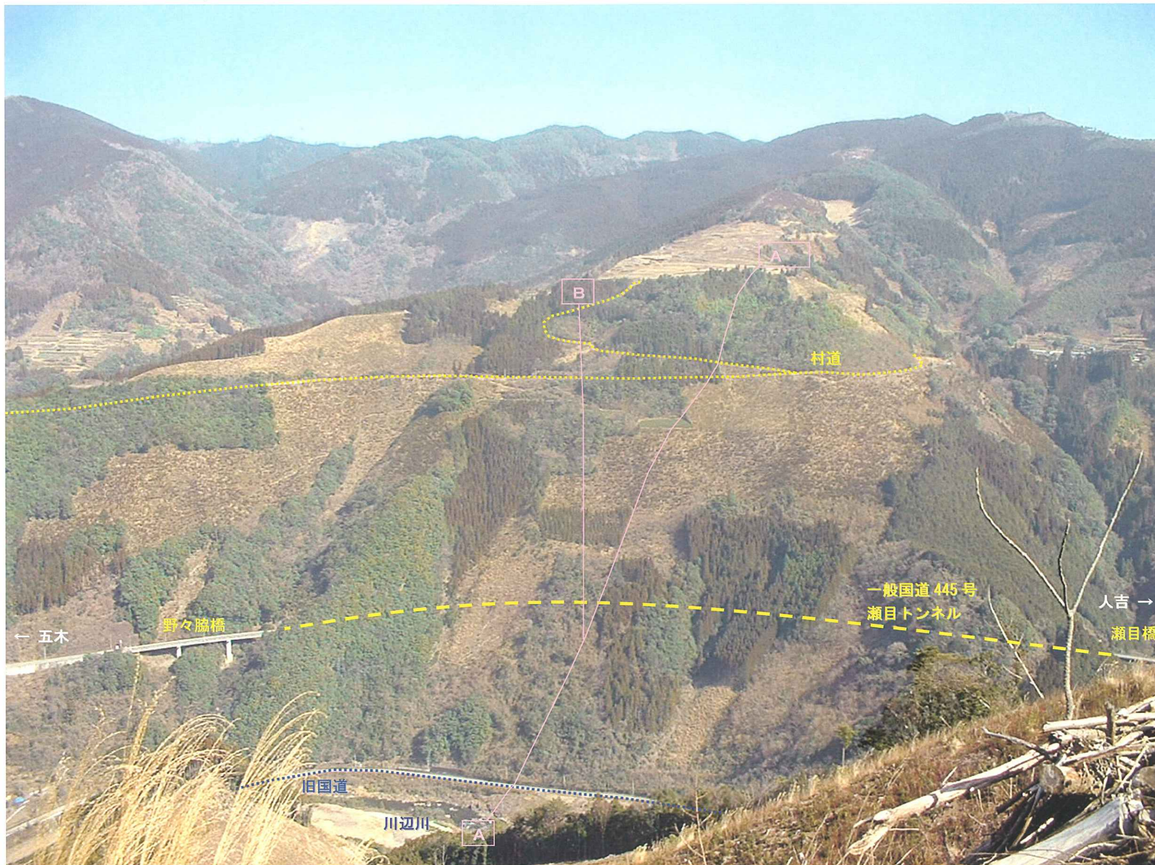
瀬目トンネル周辺斜面 全景（川辺川右岸側より望む）
