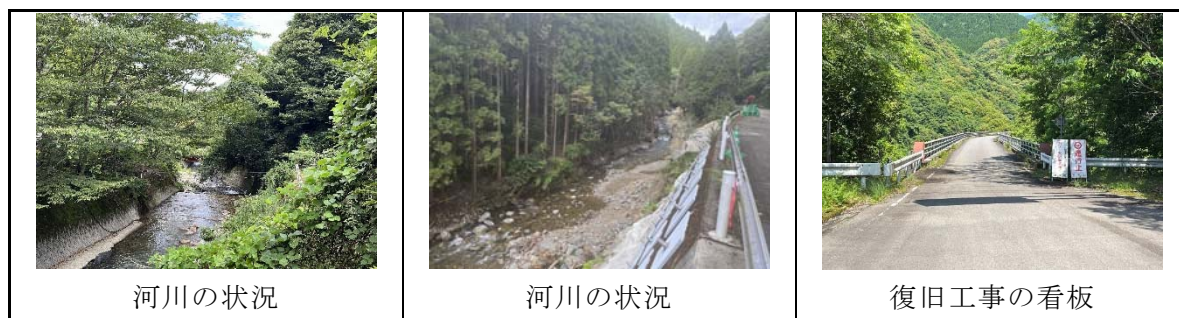
写真 7.2.10-5 椎葉谷川における利用環境の状況
