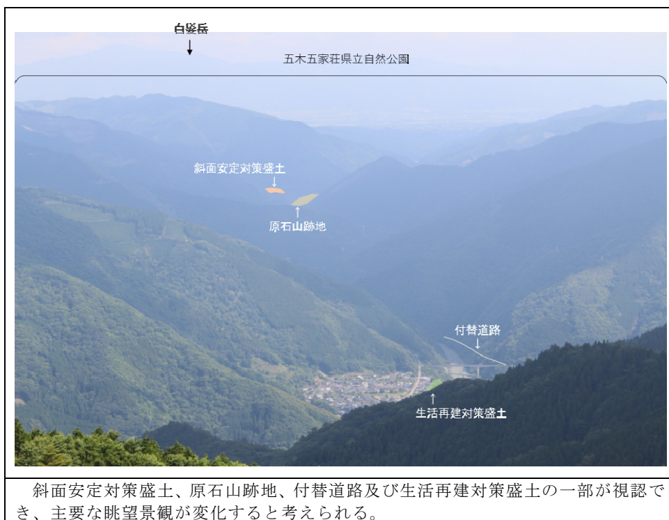
写真 7.2.9-19 国見山からの供用後の眺望景観の状況(夏季)
