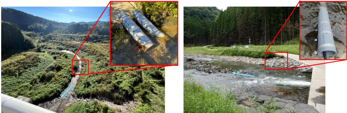
図 2-15 辰巳ダム（左）、玉来ダム（右）の濁度計設置状況
