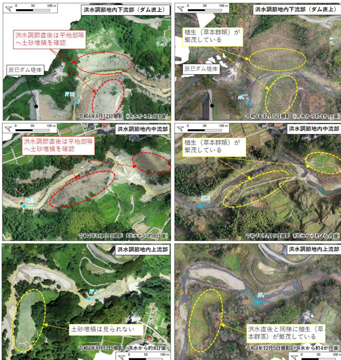
図2-7 既往流水型ダム（辰巳ダム）の洪水直後（左）と洪水から約4か月後（右）のダム洪水調節地内土砂堆積状況写真
