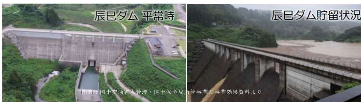
図 2-6 既往流水型ダム（辰巳ダム）の平常時（左）と洪水調節時（右）の写真
