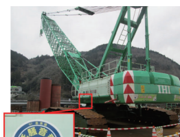
低騒音型建設機械の状況
