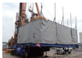
防音シートの設置の状況
