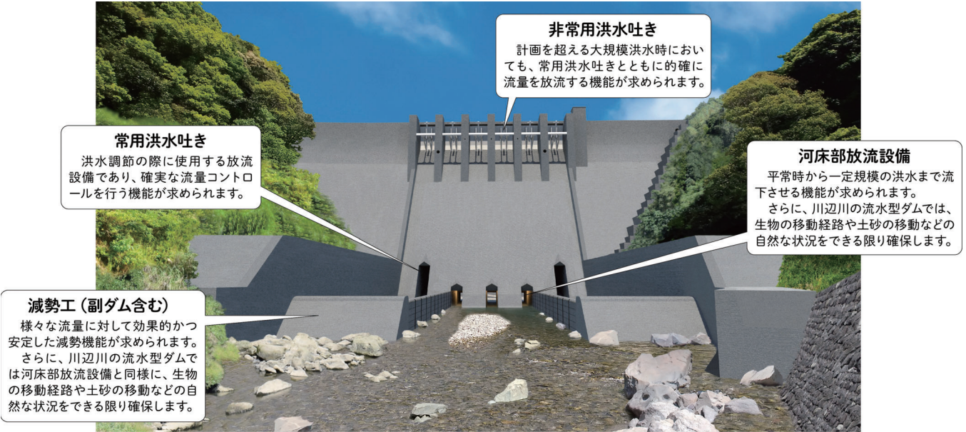
川辺川の流水型ダムのイメージ (ダム下流水面付近から望む) ※本イメージは、現時点の設計案に基づき作成しており、今後変更の可能性があります。
