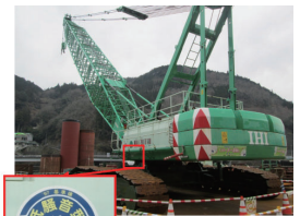
低騒音型建設機械の状況
