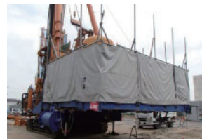
防音シートの設置の状況
