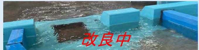
魚類(アユ)の移動の障壁とならないよう、移動経路とするスリットの幅や敷高を追求
