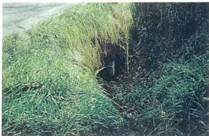
図 4.4.2.3-6 横断管の設置状況
