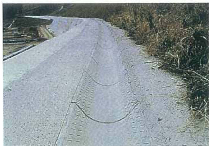
図 4.4.2.3-8 緩傾斜側溝の設置状況
