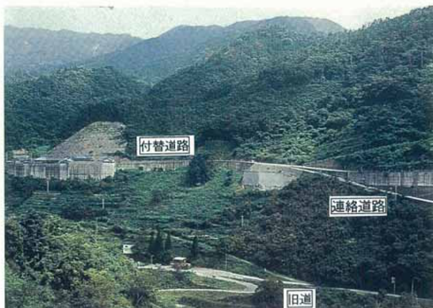
図 4.4.2.3-9 道路が移動を阻害している場所
