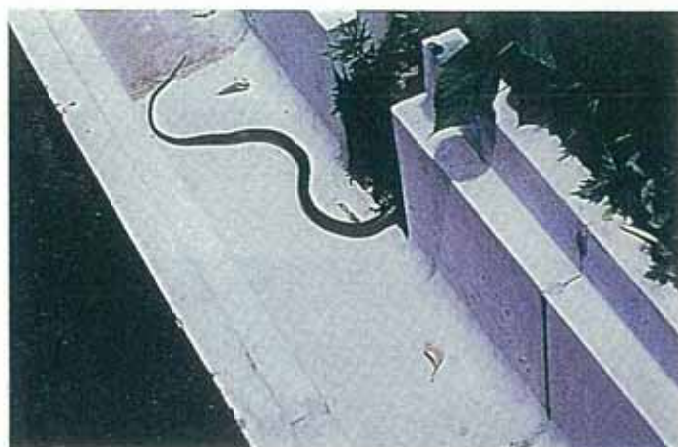
図 4.4.2.3-7 切り欠きの設置状況
