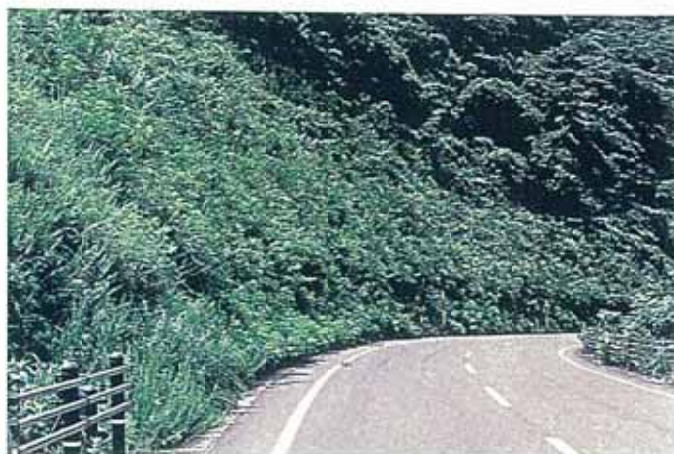
図 4.4.2.3-5 掘削法面の植栽
