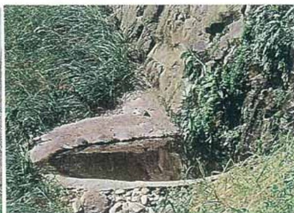
図 4.4.2.6-10 下手地区の付替道路下に設けられた水飲み場
