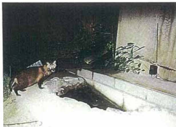
図 4.4.2.6-11 松本地区の付替道路の橋下部に設けられた水飲み場
