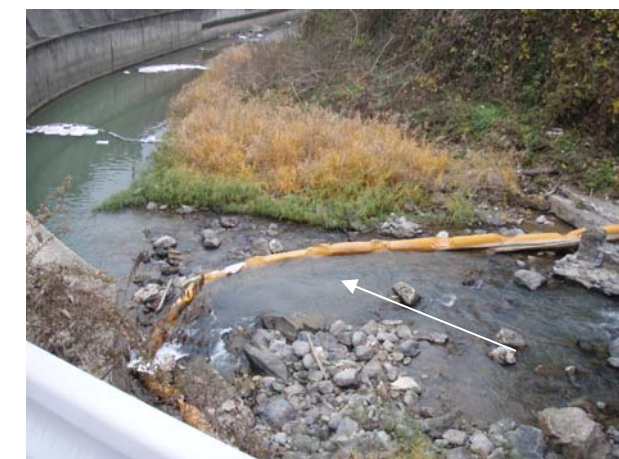
水質事故対応(オイルフェンス設置)
