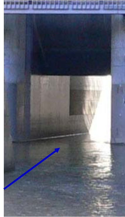
【常用洪水吐の状況】
