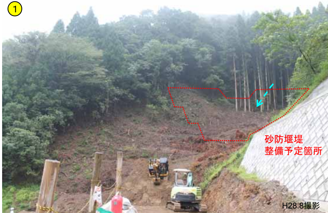
砂防堰堤整備予定箇所 (伐採が完了し、掘削作業に着手)
