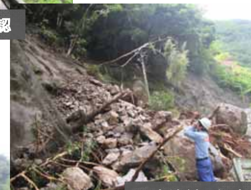
崩壊斜面調査
