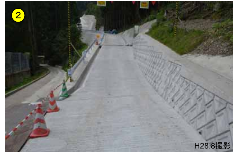
工事(管理)用道路
