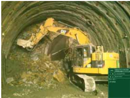
トンネル掘削作業
