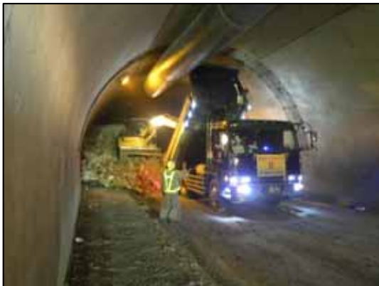
既設トンネルの閉塞作業
