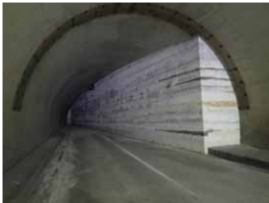
トンネル分岐点の人工地山 (エアミルク充填)
