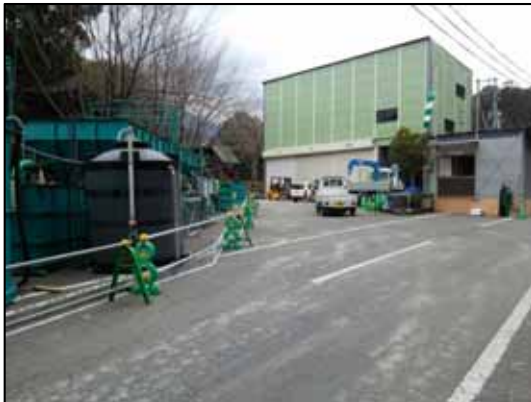
仮設備の設置(瀬目公園)
