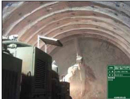
コンクリート吹付作業
