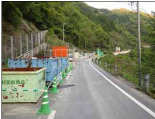
仮設備の設置(現道)
