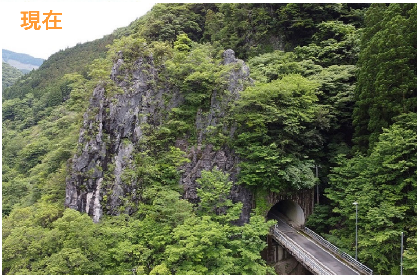
環境に配慮した道路計画(明神岩トンネル) 植生保存工事 多くの貴重植物を保全
