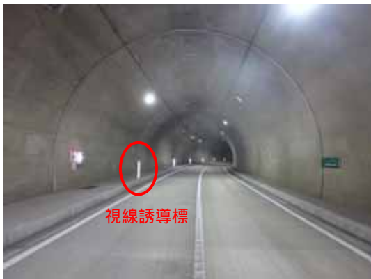
トンネル工事完了
