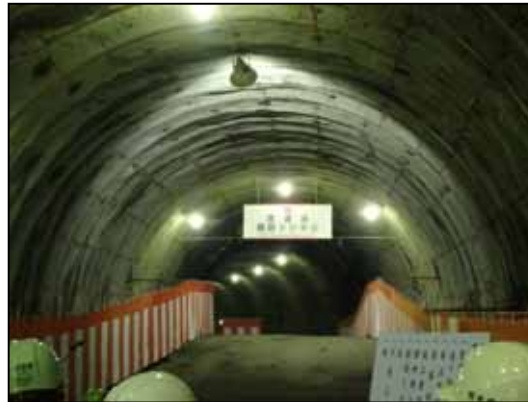
トンネル貫通式 (平成28年9月1日)
