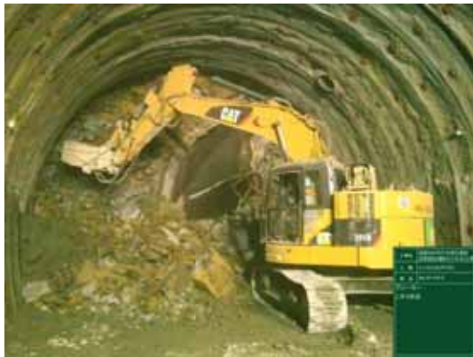
トンネル掘削作業
