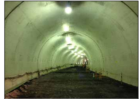
覆工コンクリート工状況
