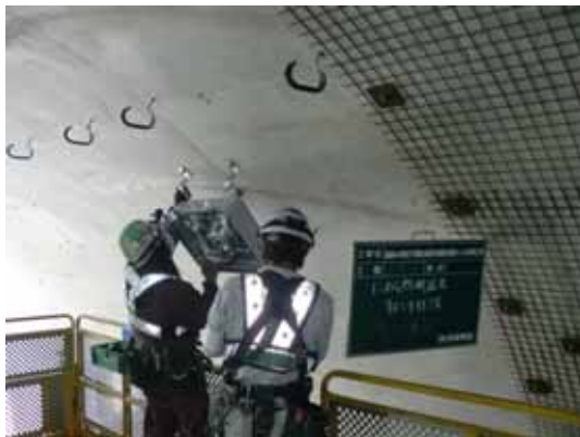
照明設置状況
