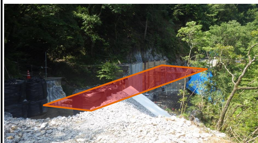
村道神屋敷線—橋梁上部工工事等
