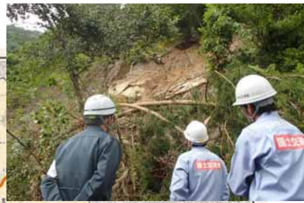
現地での工法検討に向けた 技術的助言【村道川辺川線】
