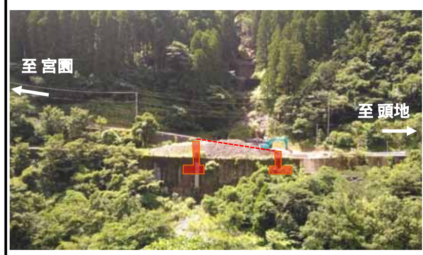
村道神屋敷線 - 橋梁下部工工事等
