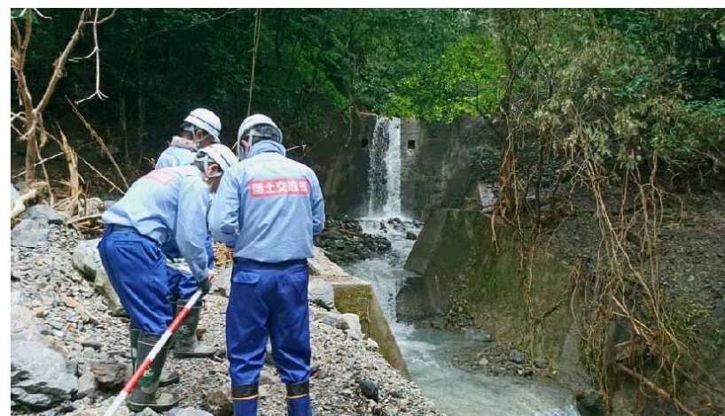
三方谷川砂防堰堤1の調査
