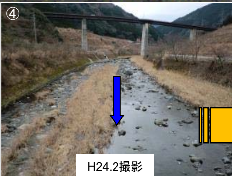
土砂流出による堆砂状況（五木小川1k200地点）
