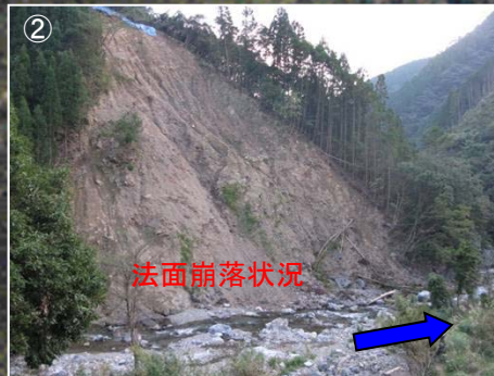
土砂流出による堆砂状況（五木小川1k200地点）
