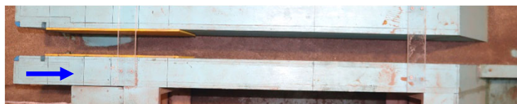
河床部放流設備内の石礫の堆積状況
