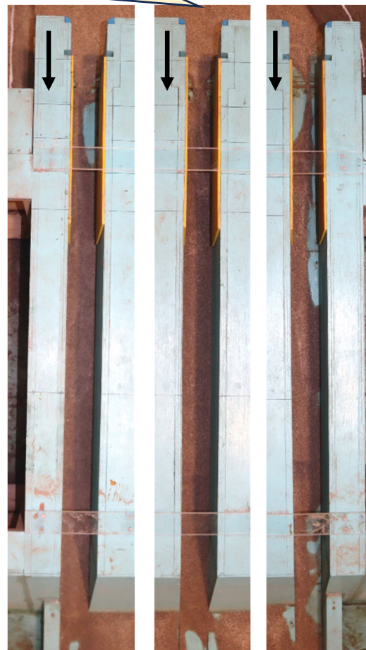
⑤ 通水後 河床部放流設備内
