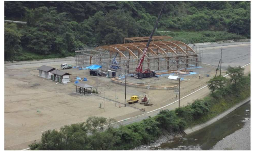
健康・交流広場(仮称)整備工事(大屋根広場)写真 (H26.9.1現在)
