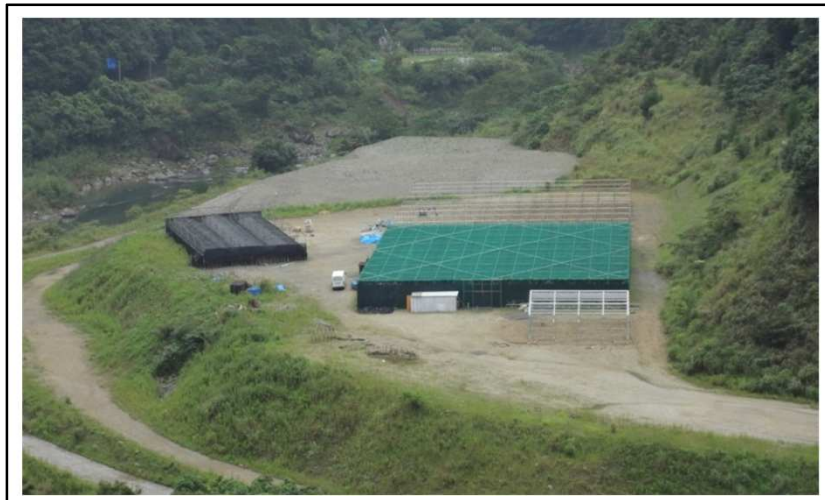
清楽地区椎茸栽培施設整備工事写真 (H26.9.1現在)
