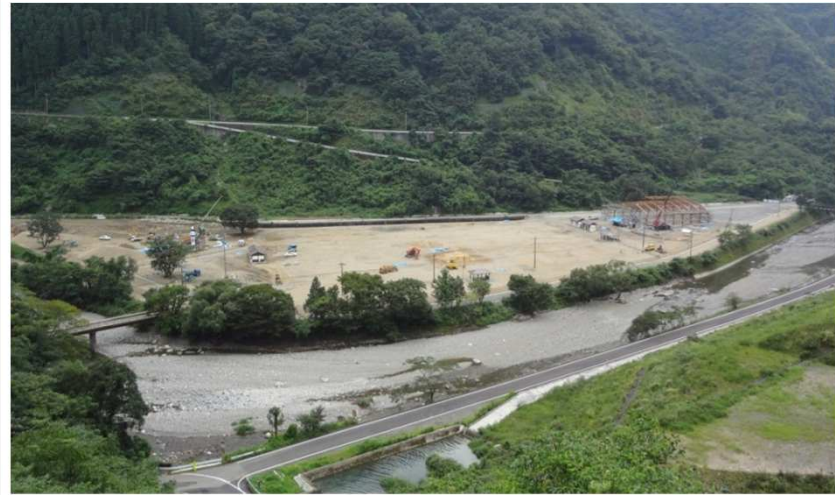
健康・交流広場(仮称)整備工事写真(H26.9.1現在)
