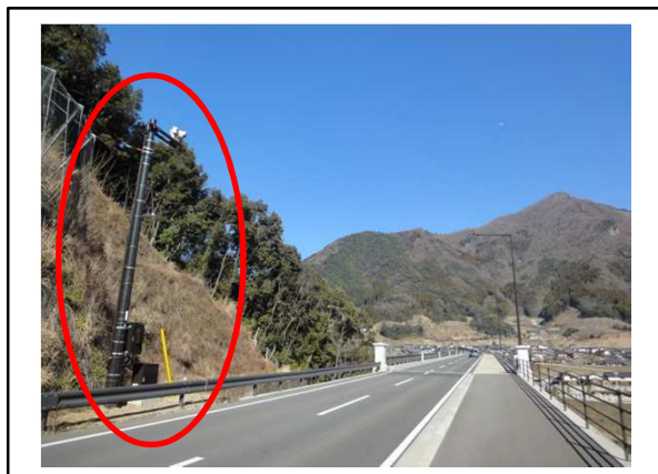
頭地大橋(高野側)
