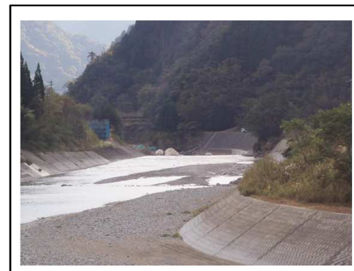
村道鶴線(橋梁架設)
