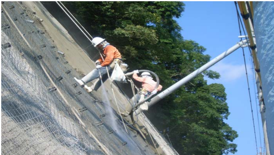
高圧洗浄機にてリバウンド清掃状況
