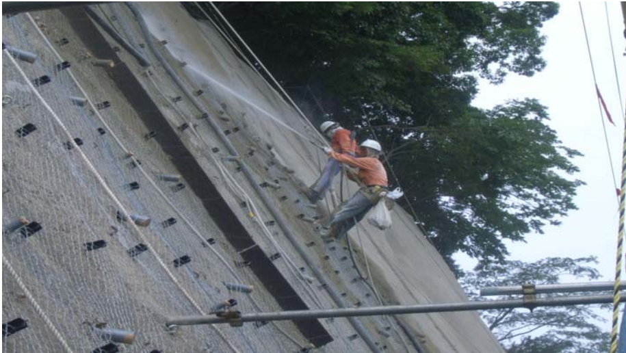
高圧洗浄機にてリバウンド清掃状況
