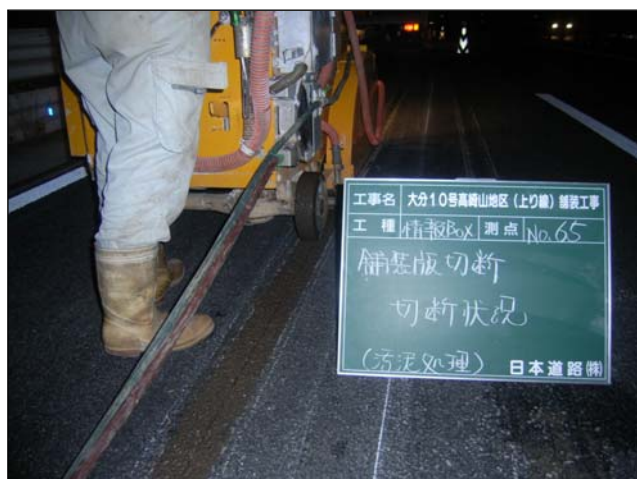
舗装版切断状況
