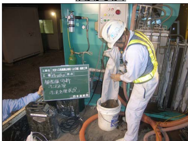
汚泥処理完了
